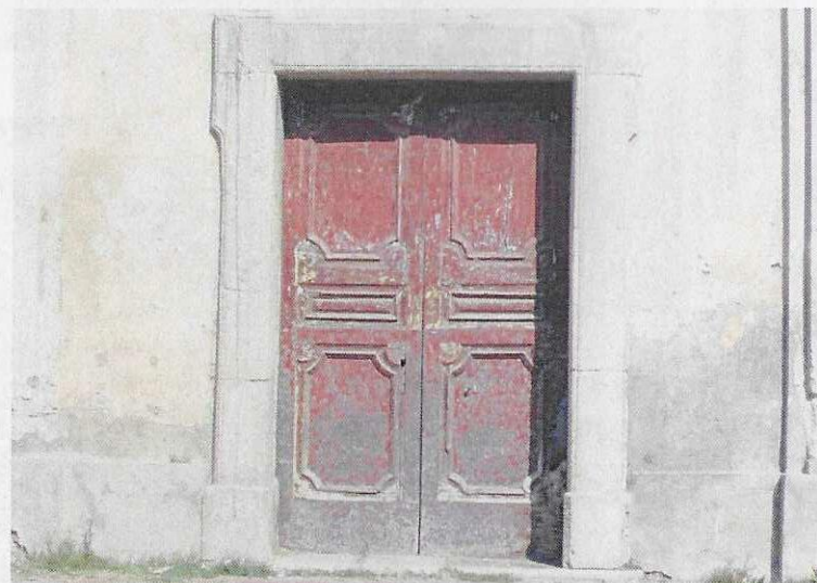
Il portale settecentesco, sostituito nel restauro del 2008.
